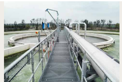
Biologie mit Nitrifikation und Denitrifikation
