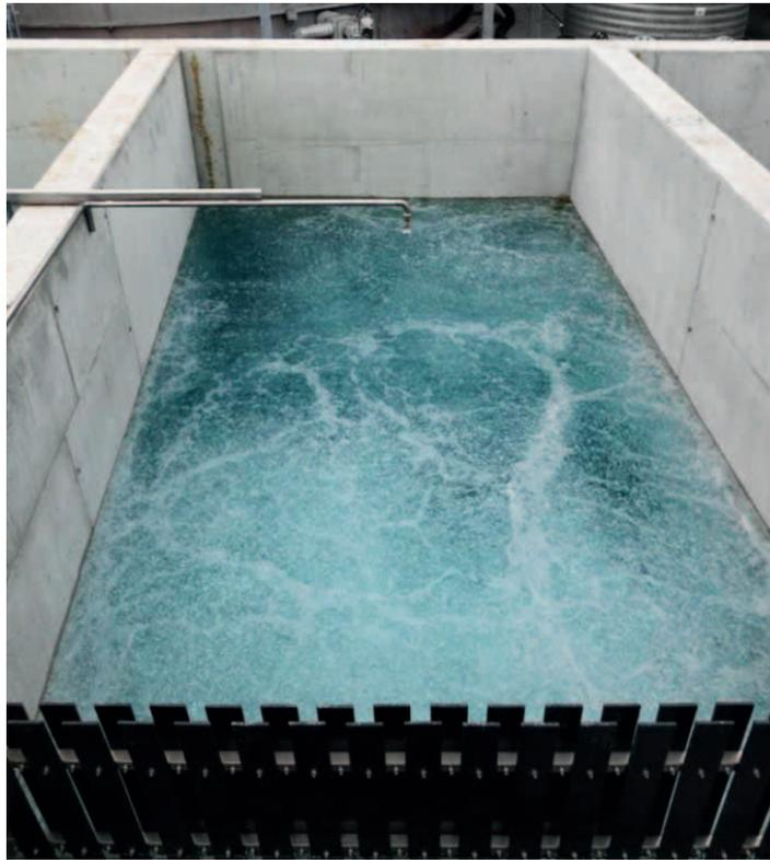
BIOFIT®.F als biologische Filtrationsstufe ist die ideale Ergänzung als Nachfolgestufe zu BIOFIT®.Oxyd<sup>2</sup> um eine möglichst effiziente und kostengünstige Verfahrenskombination zu erhalten.
