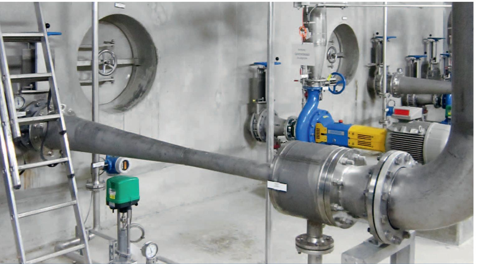
BIOFIT®.Oxyd<sup>2</sup> – AOP-Verfahren zum Abbau von hartem CSB
